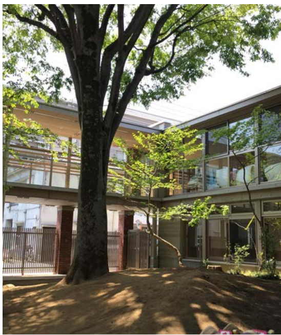
日暮里保育園 (東京都荒川区)
